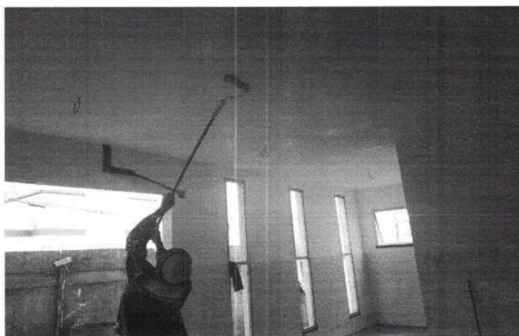
PINTURA DOS TETOS
