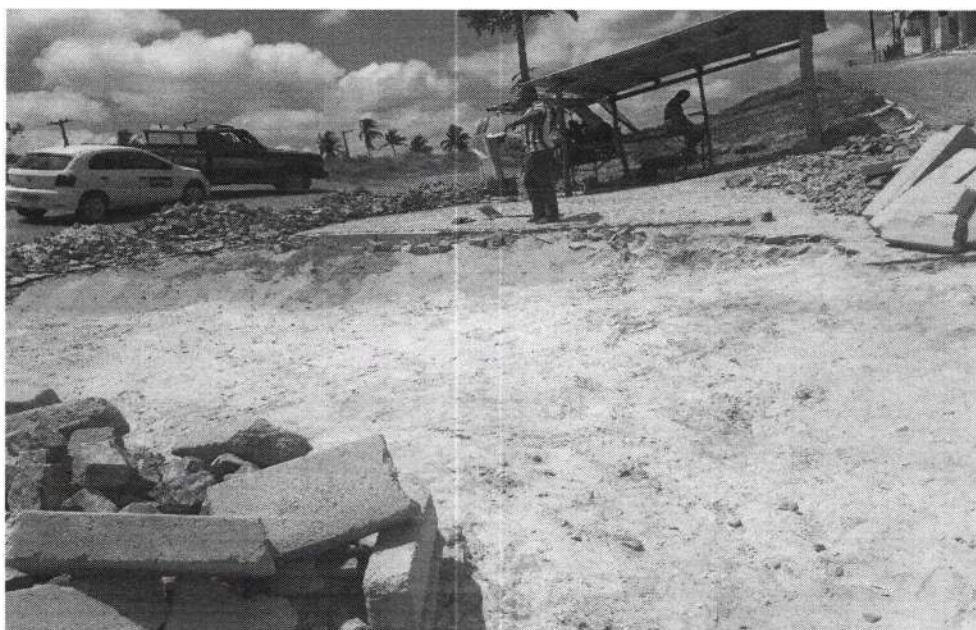
SERVIÇO DE RECUPERAÇÃO NA ENTRADA DO POV. MINANTE
