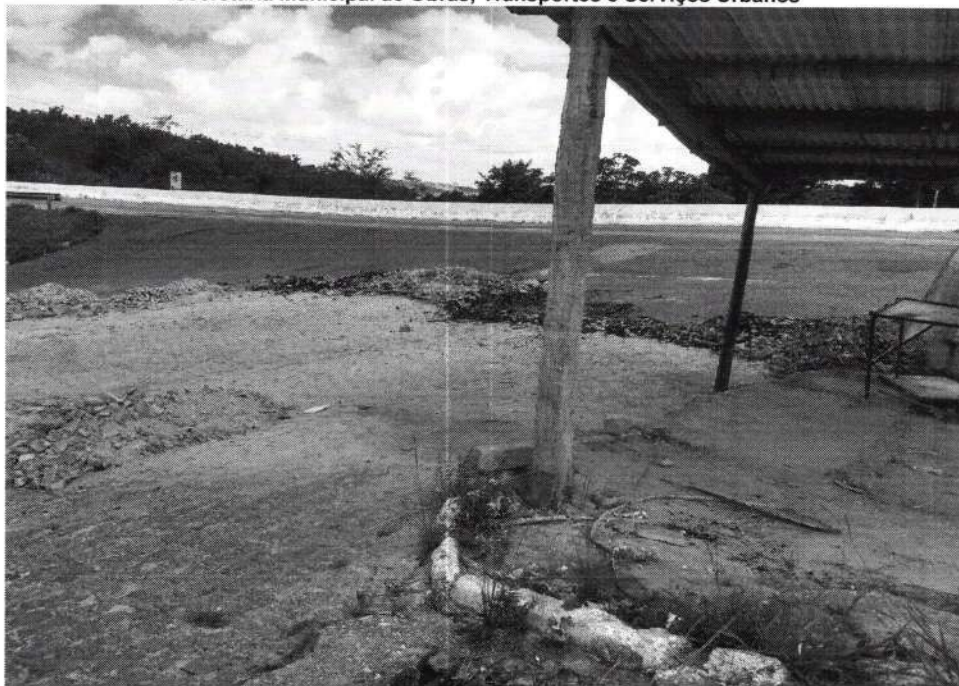
AGUARDANDO A CURA DO CONCRETO PARA FAZER A LIMPEZA DA ÁREA (POV. MINANTE)
