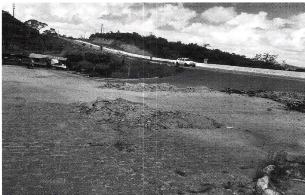
AGUARDANDO A CURA DO CONCRETO PARA FAZER A LIMPEZA DA ÁREA (POV. MINANTE)
