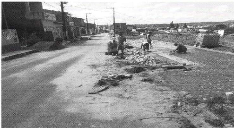
PAVIMENTAÇÃO NO ESTACIONAMENTO DO MIRANTE
