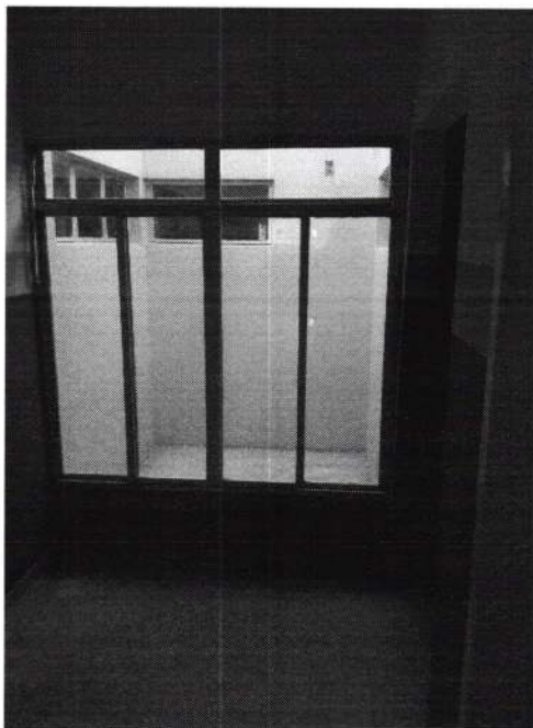
ÁREA DE VENTILAÇÃO
