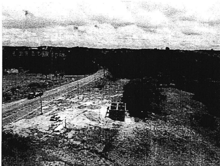
Figura 12 – Imagem aérea – Vista SUL
