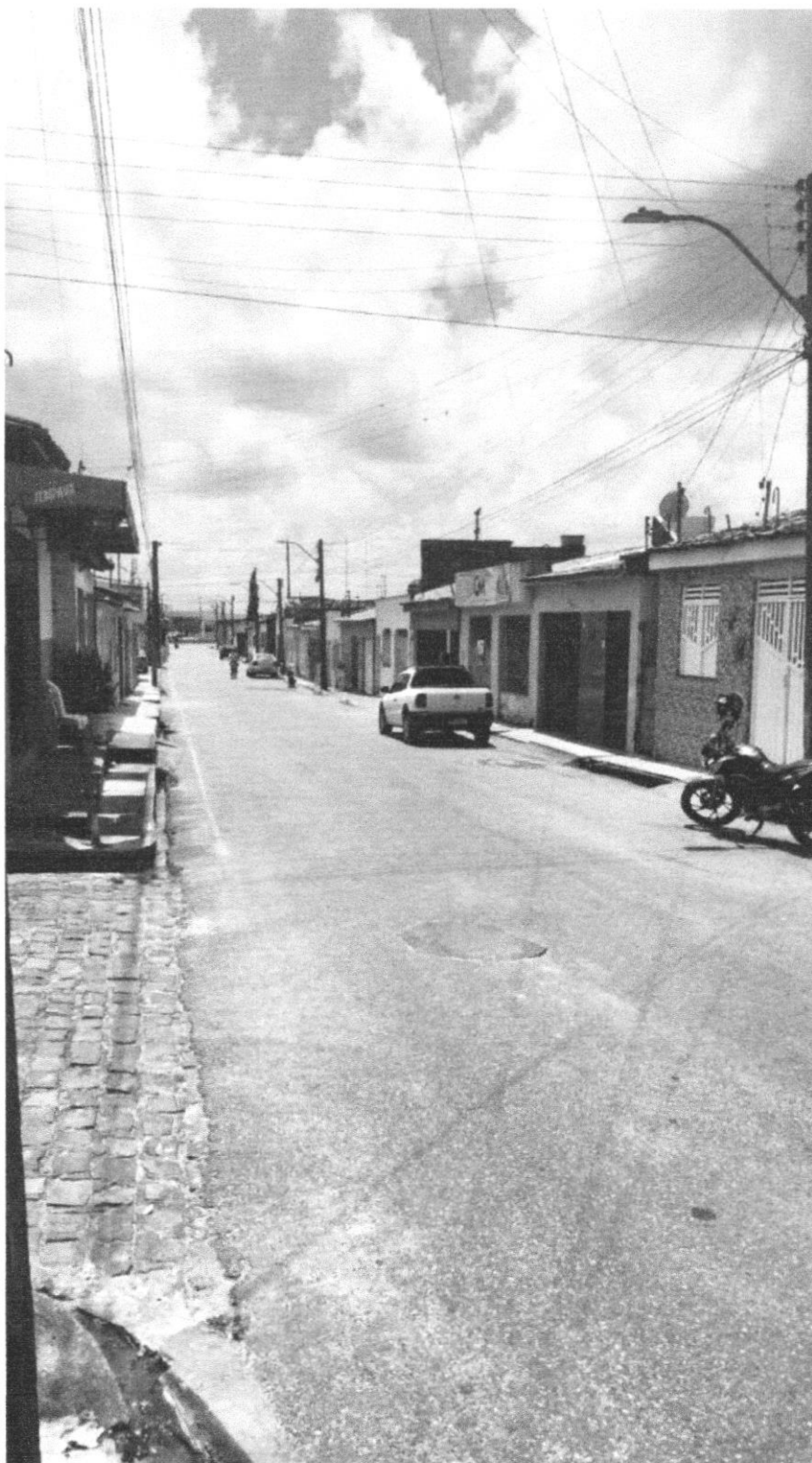
Foto 2 – Trecho da via com baixa visibilidade e ausência de redutores de velocidade.
