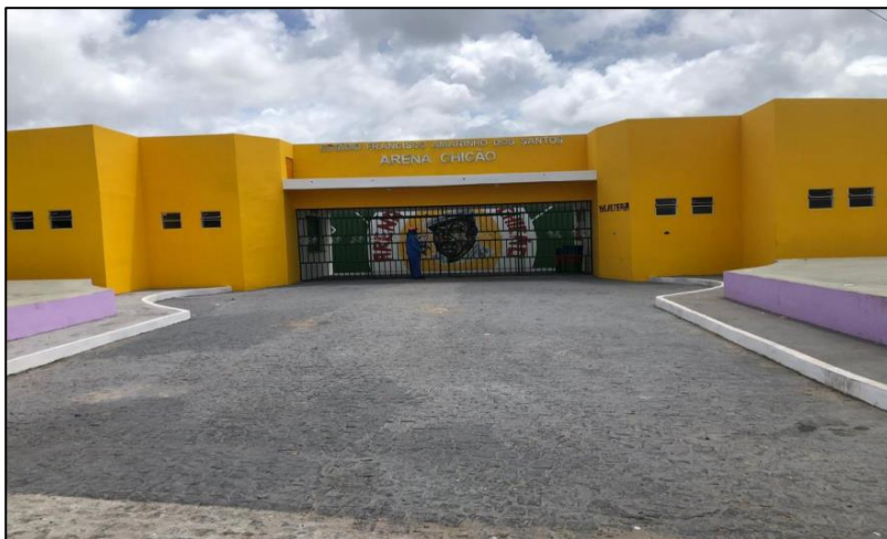
Figura 63: Reforma da Arena Chicão.
