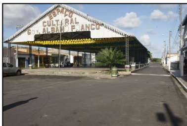
Figura 53: Pavimentação em frente ao Espaço Cultural Gov. Albano Franco.
