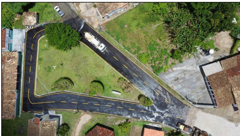
Figura 57: Pavimentação do Povoado Sítio Novo.
