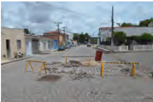
Limpeza da rede pluvial e reparos na Pavimentação
