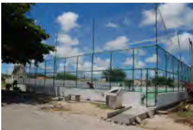
Reforma da quadra do Conjunto Senhor dos Passos
