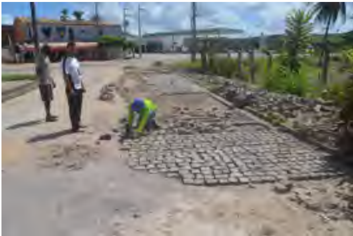
Reparo na pavimentação da rua do Maruim
