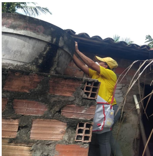
INSPEÇÃO DE CAIXA D'ÁGUA
