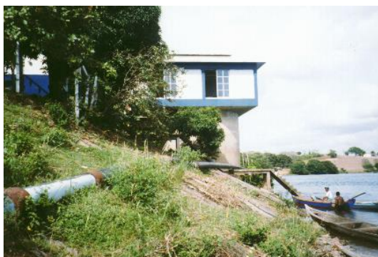
Vista geral da torre de tomada e da Casa de Bombas
