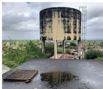
Vista geral do reservatório elevado
