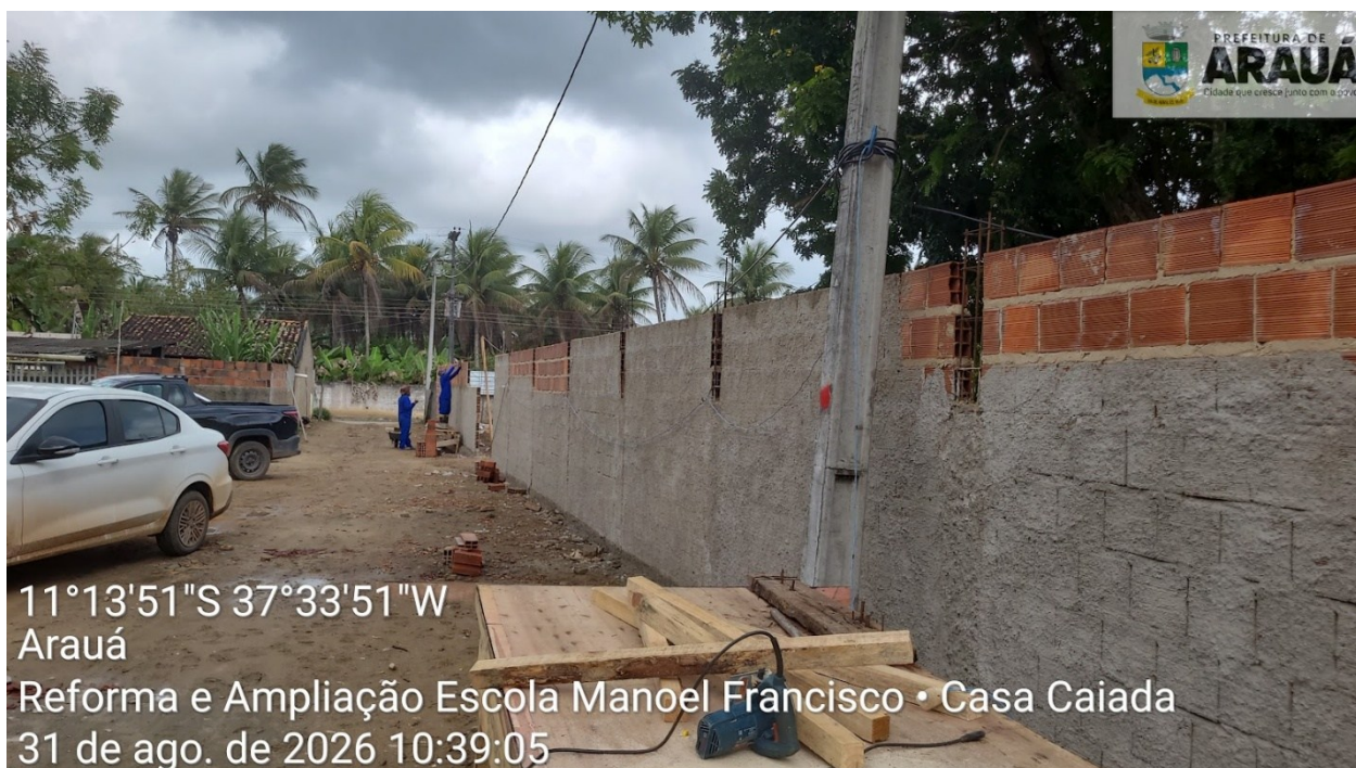
Muro lateral em alvenaria e chapisco
