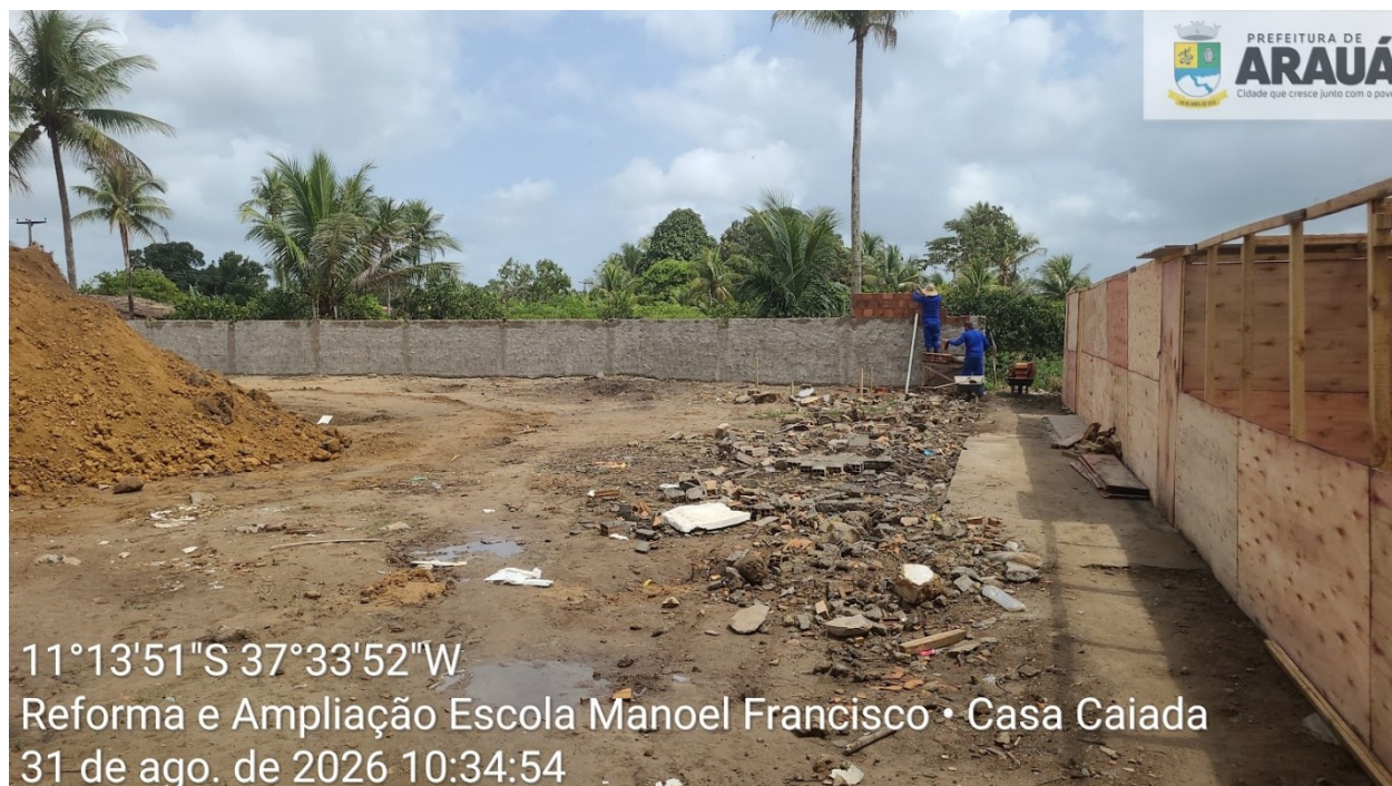
Vista do interior da obra e barracão
