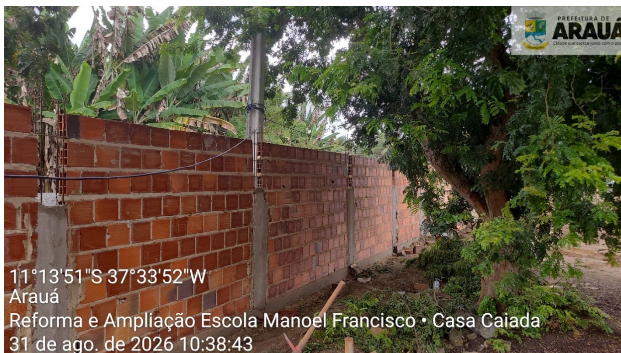
Pilares de concreto e alvenaria do muro lateral
