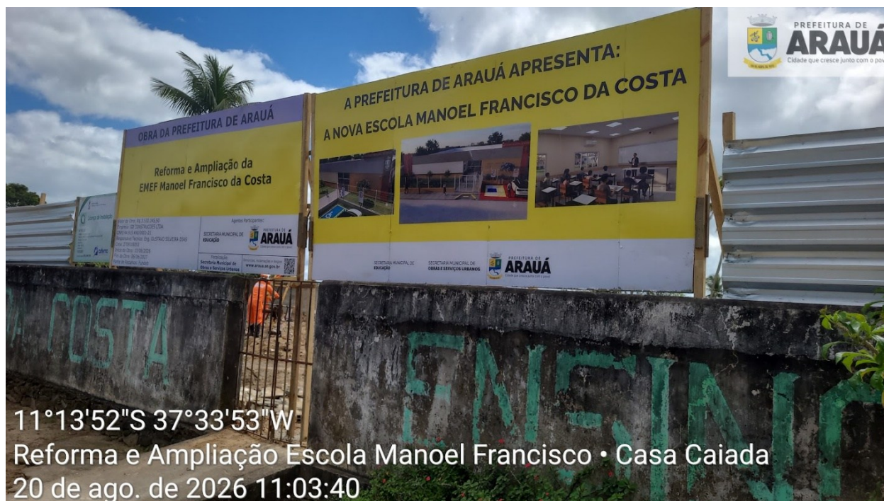
Placa da Obra e Fechamento da obra com tapume metálico
