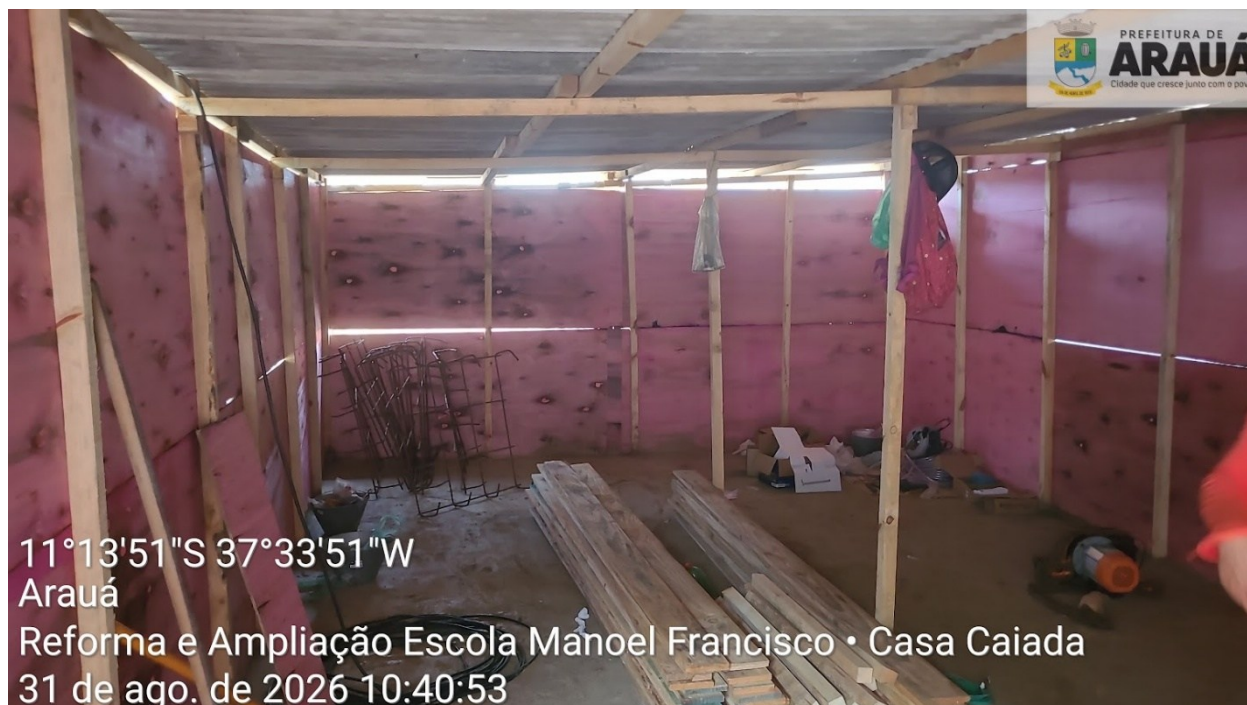
Barracão para depósito e almoxarifado
