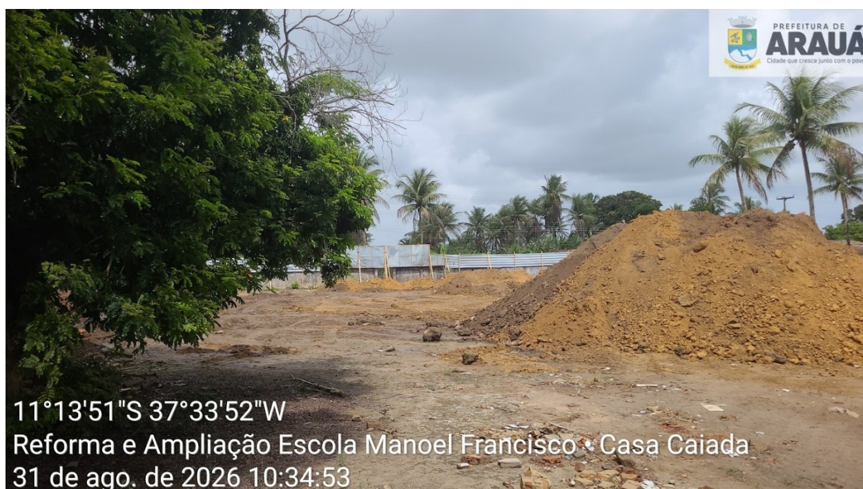
Movimentação de terra do interior da obra
