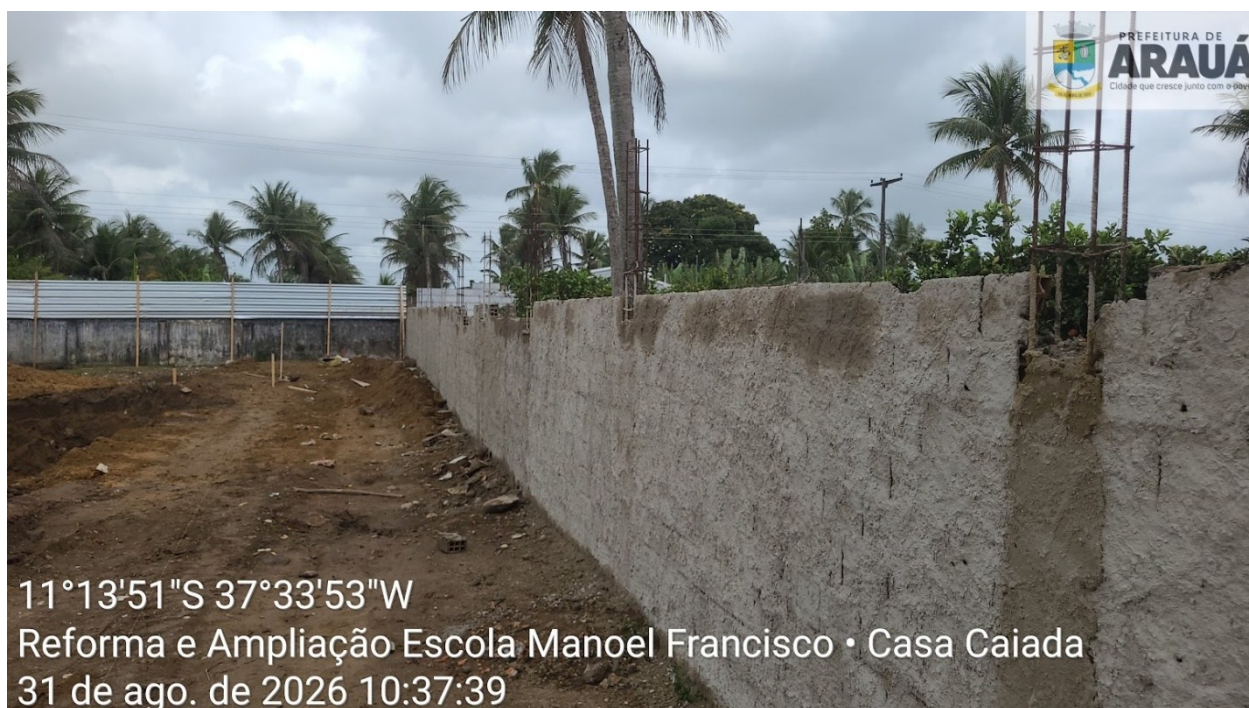
Fechamento do muro em alvenaria das laterais
