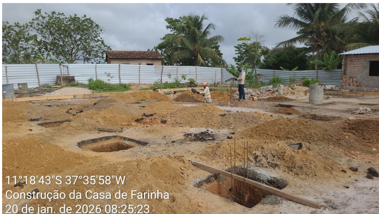
Escavação das sapatas e Locação da Obra
