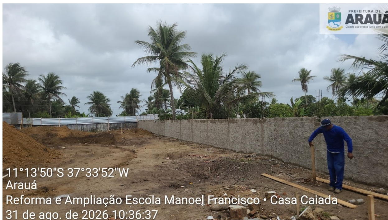
Muro lateral em alvenaria com chapisco
