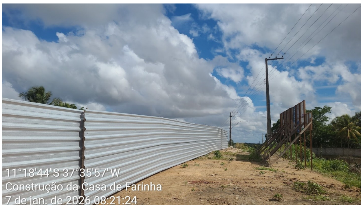
Fechamento da obra com tapume metálico
