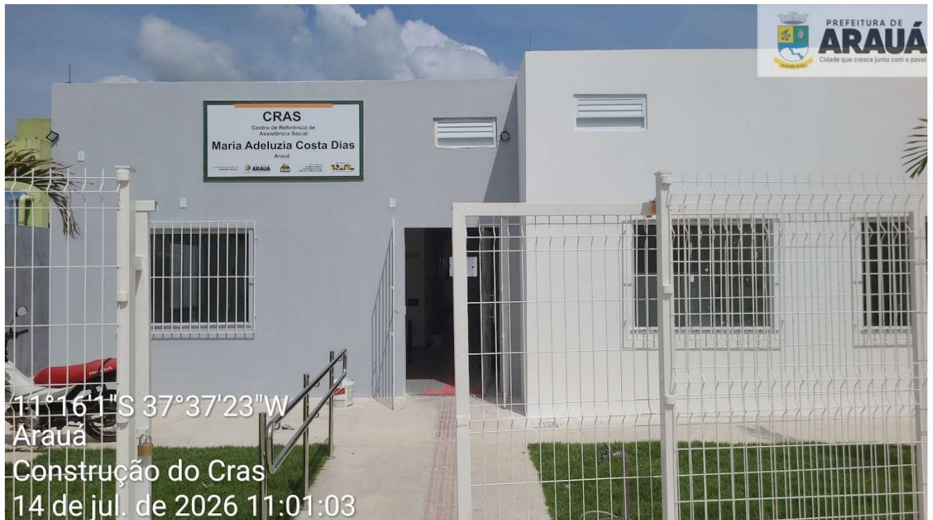
Frente da obra
