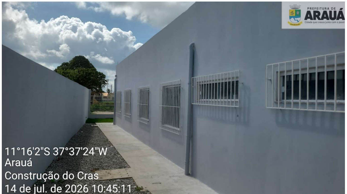
Lateral da Obra
