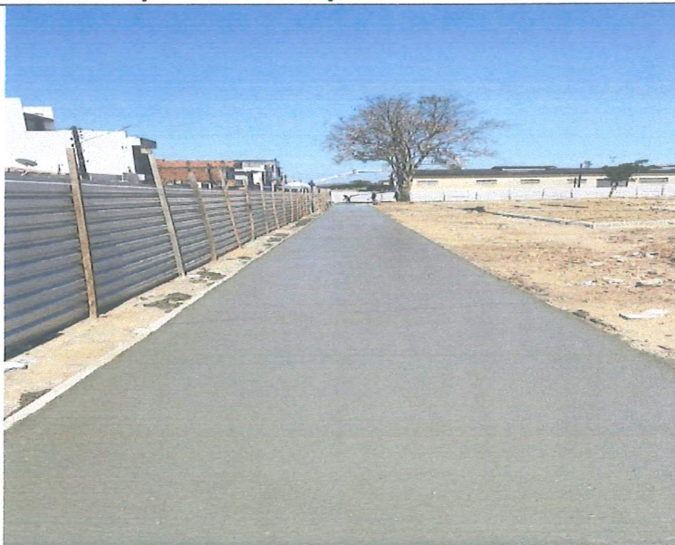
FORNECIMENTO E INSTALAÇÃO DE TELA AÇO SOLDADA
