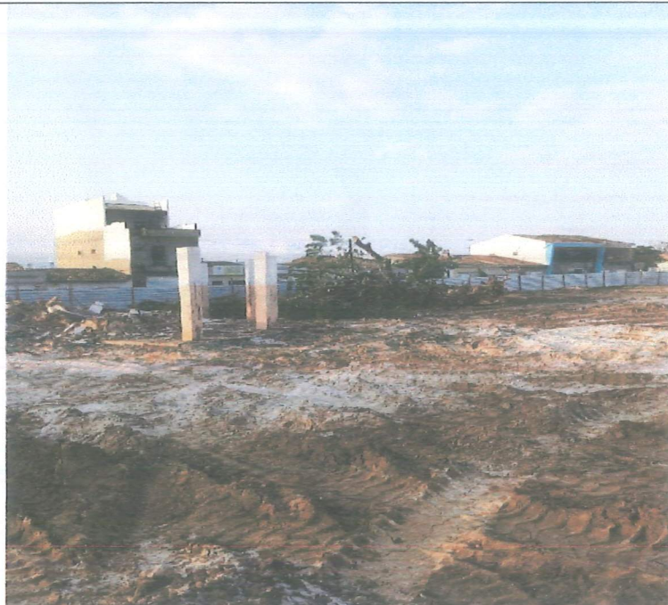
DESTOCAMENTO DE ÁRVORES DE PORTE MÉDIO E RAÍZES PROFUNDAS, SEM AUXÍLIO MECÂNICO
