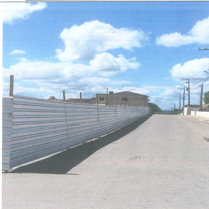
TAPUME COM TELHA METÁLICA. AF_03/2024
