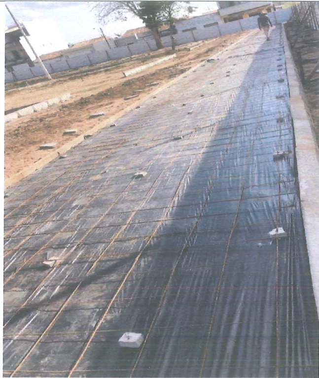
FORNECIMENTO E INSTALAÇÃO DE TELA AÇO SOLDADA;
