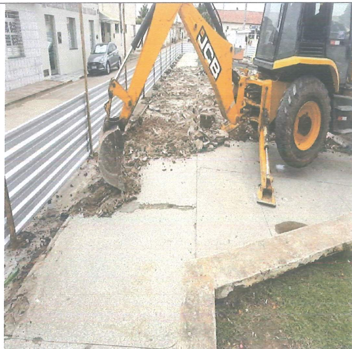
DEMOLIÇÃO DO PISO DE ALTA RESISTÊNCIA
