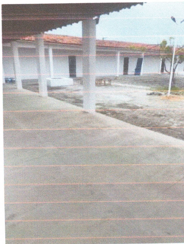
FOTO 5 – EMASSAMENTO E PINTURA DE ACABAMENTO, GERAL;
