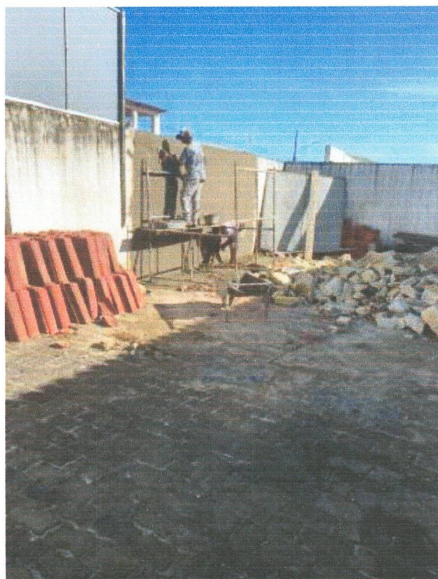
FOTO 3 – EXECUÇÃO DE REBOCO;
