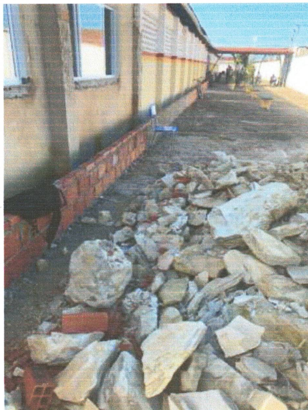
FOTO 2 – DEMOLIÇÕES E EXECUÇÃO DE ALVENARIA;
