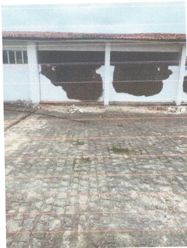
FOTO 4 – REGULARIZAÇÃO PARA POSTERIOR ASSENTAMENTO DE JANELAS;
