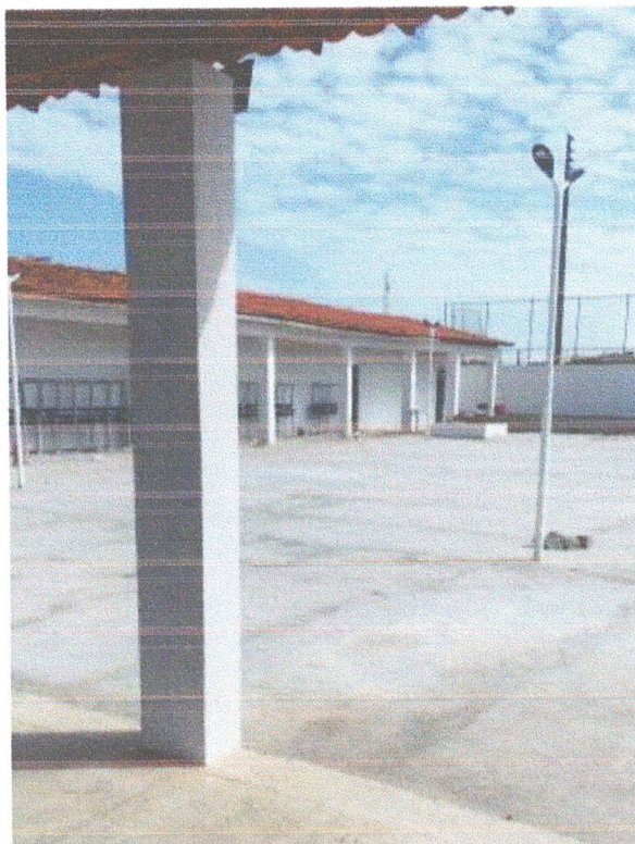
FOTO 6 – EMASSAMENTO E PINTURA DE ACABAMENTO, GERAL;
