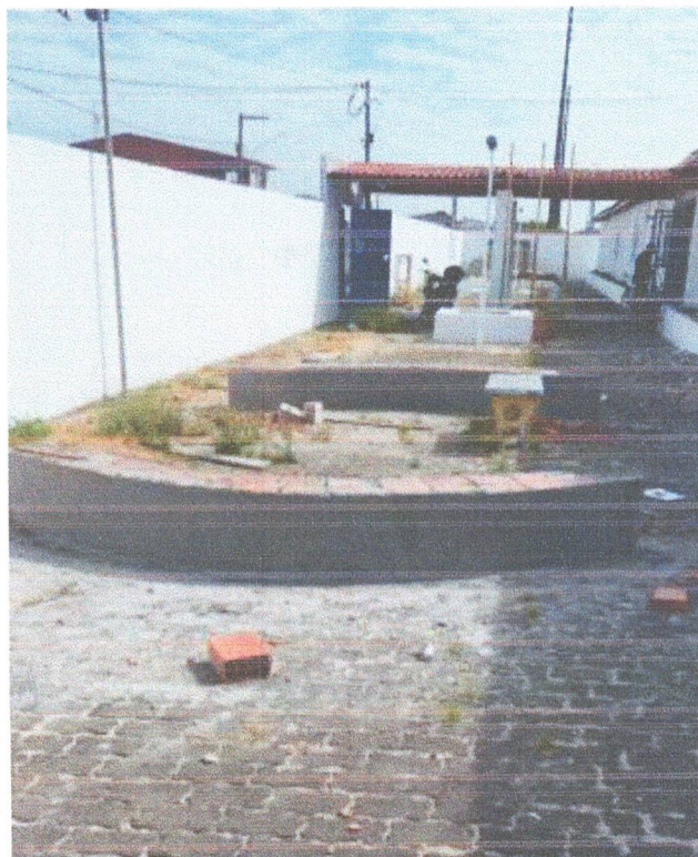
FOTO 9 – SERVIÇOS DE ALVENARIA; CHAPISCO E REBOCO;
