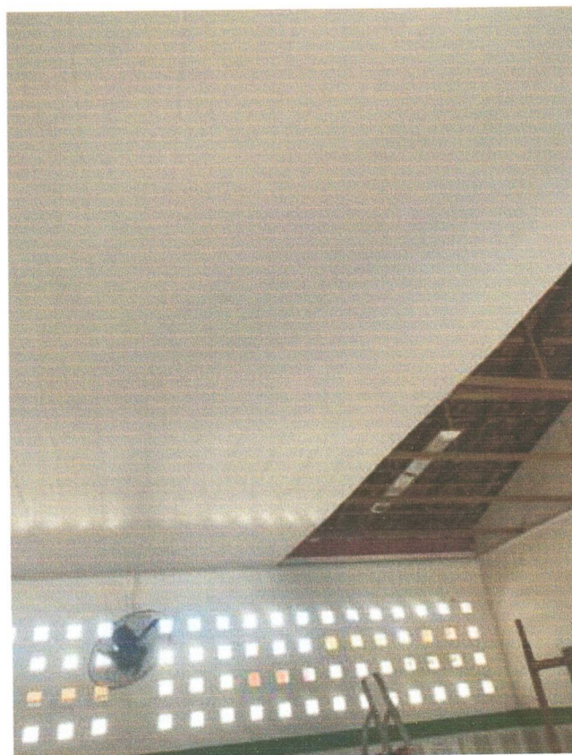
FOTO 3 – INSTALAÇÃO DE FORRO PVC;
