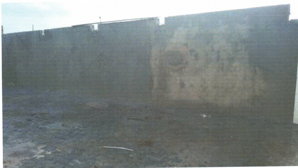
FOTO 7 – CHAPISCO E REBOCO;
