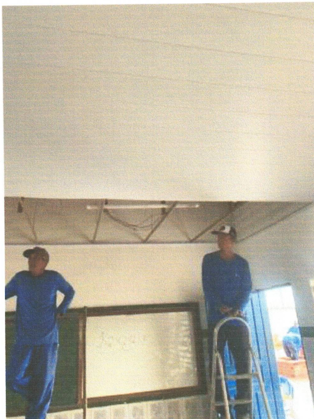
FOTO 2 – INSTALAÇÃO DE FORRO PVC;
