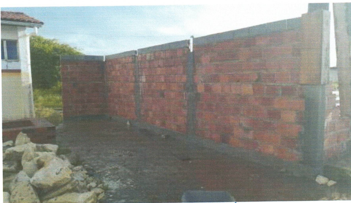
FOTO 6 – ALVENARIA DE BLOCO CERÂMICO;
