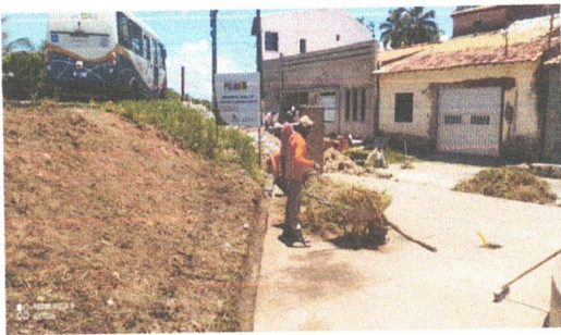
Regularização de talude
