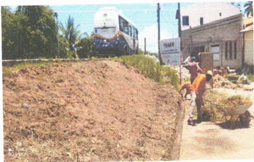
Regularização de talude
