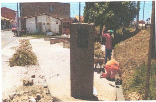
Entrada de energia
