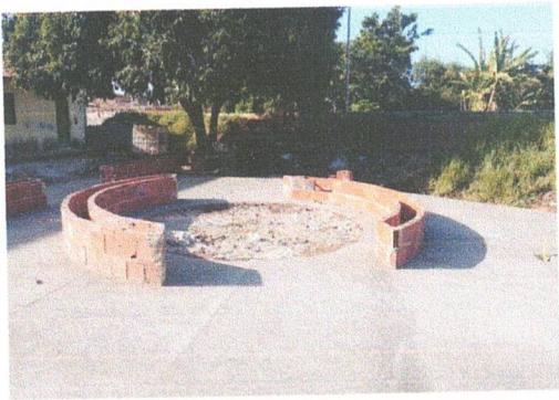
piso em concreto desempolado e banco em alvenaria
