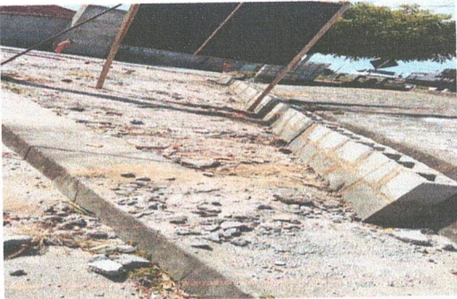
Mureta de contenção em blocos de concreto preenchido
