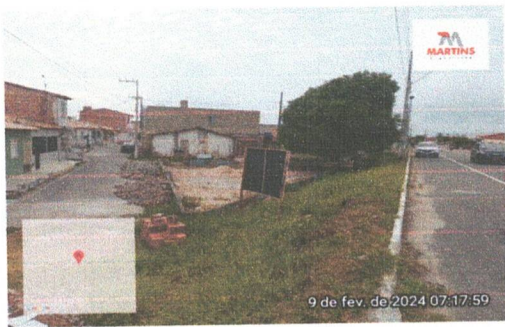
Demolição de pavimentação
