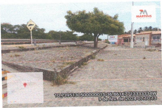
Demolição de pavimentação
