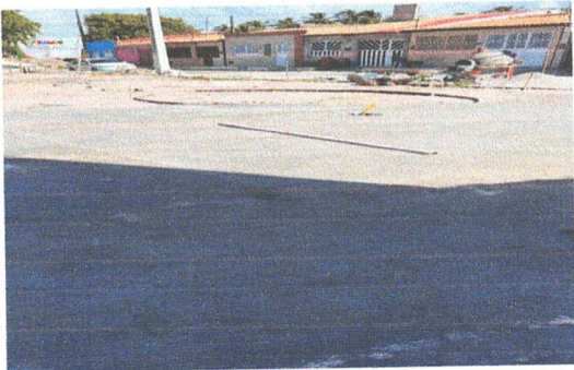
Regularização de piso e piso em concreto
