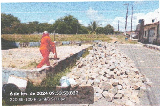
Demolição de pavimentação
