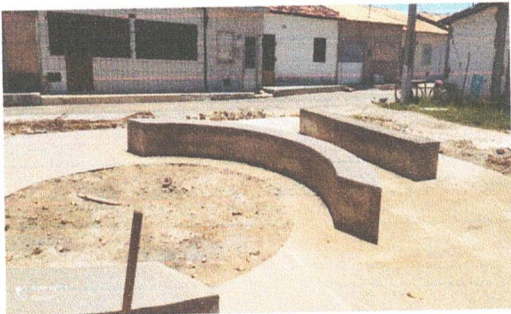
Execução de bancos
