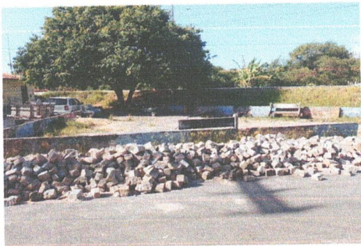
Demolição de pavimentação
