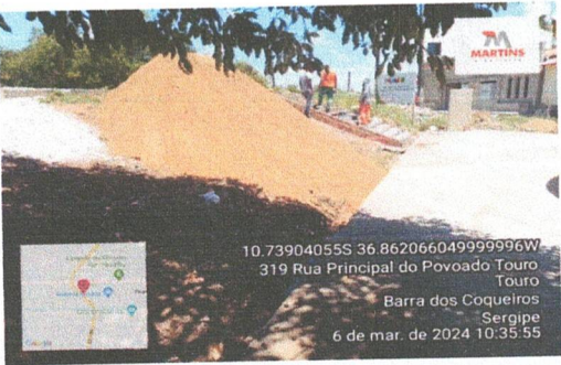
Aterro para regularização de talude
