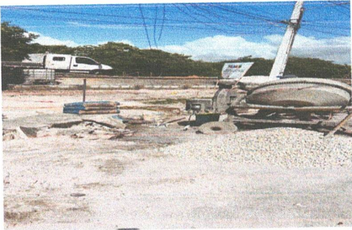
Regularização de piso e piso em concreto
