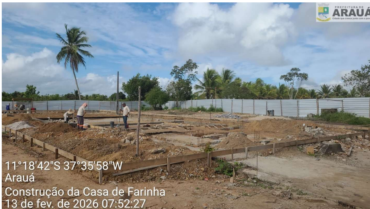
Locação da fundação
