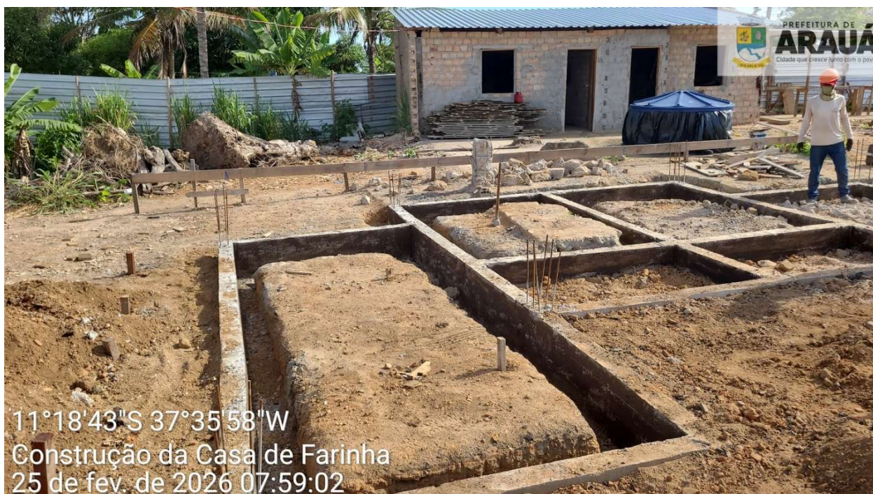
Vigas baldrame em concreto armado
