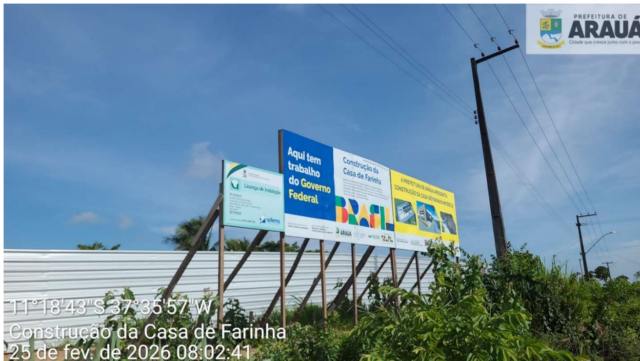
Placa de obra em chapa aço galvanizado, instalada
