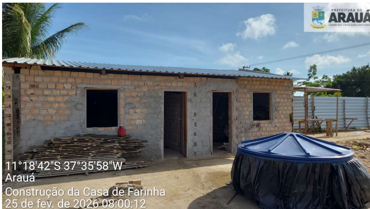
Barracão da obra
