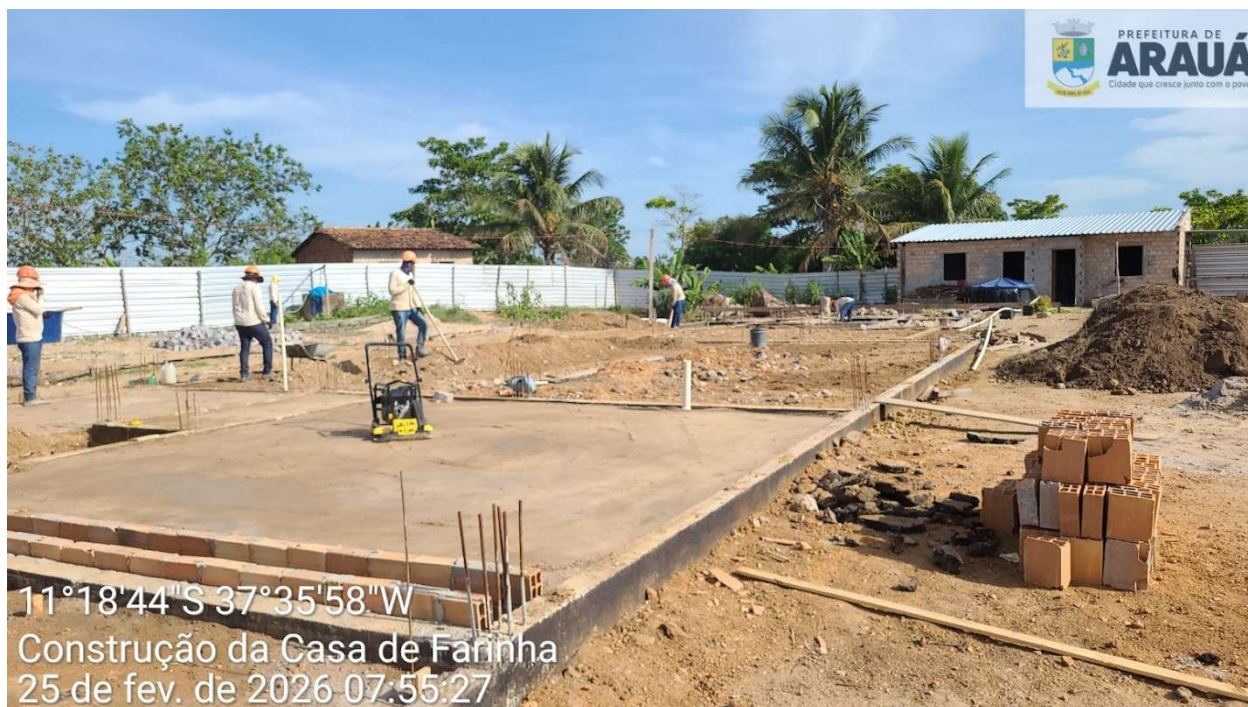
Vigas baldrame de concreto armado e tubulações de esgoto
