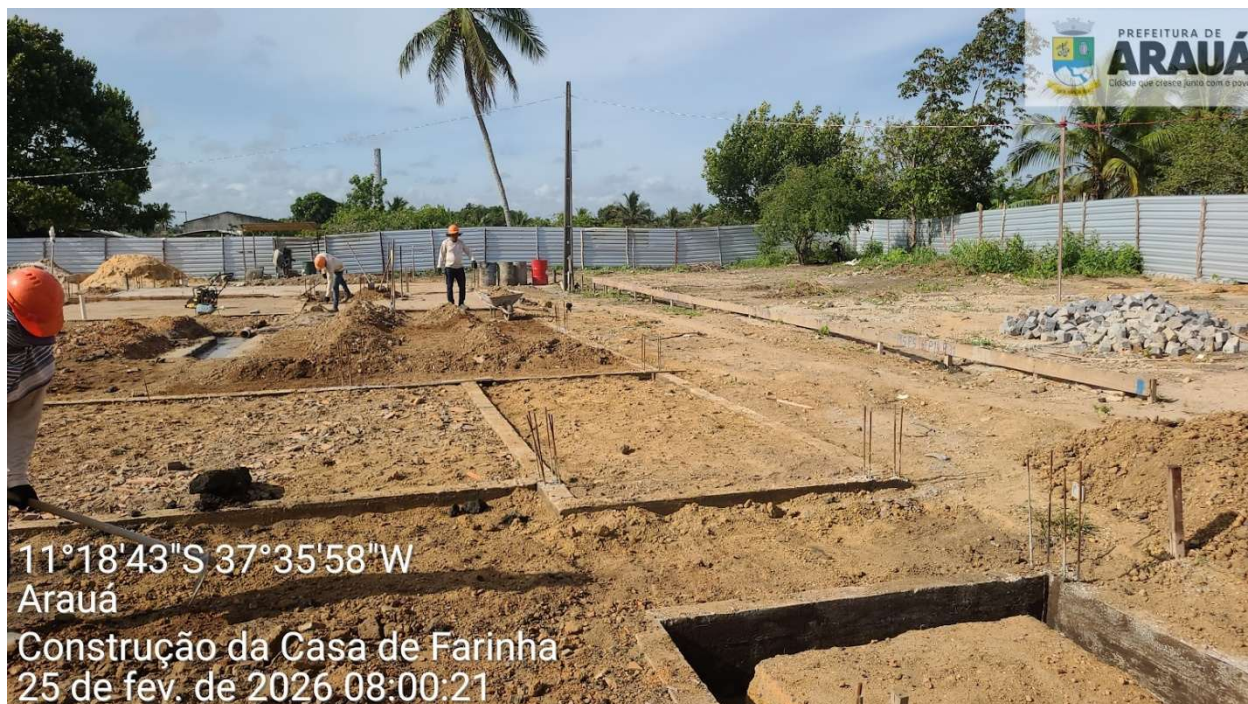
Fundação e fechamento da obra em tapume
