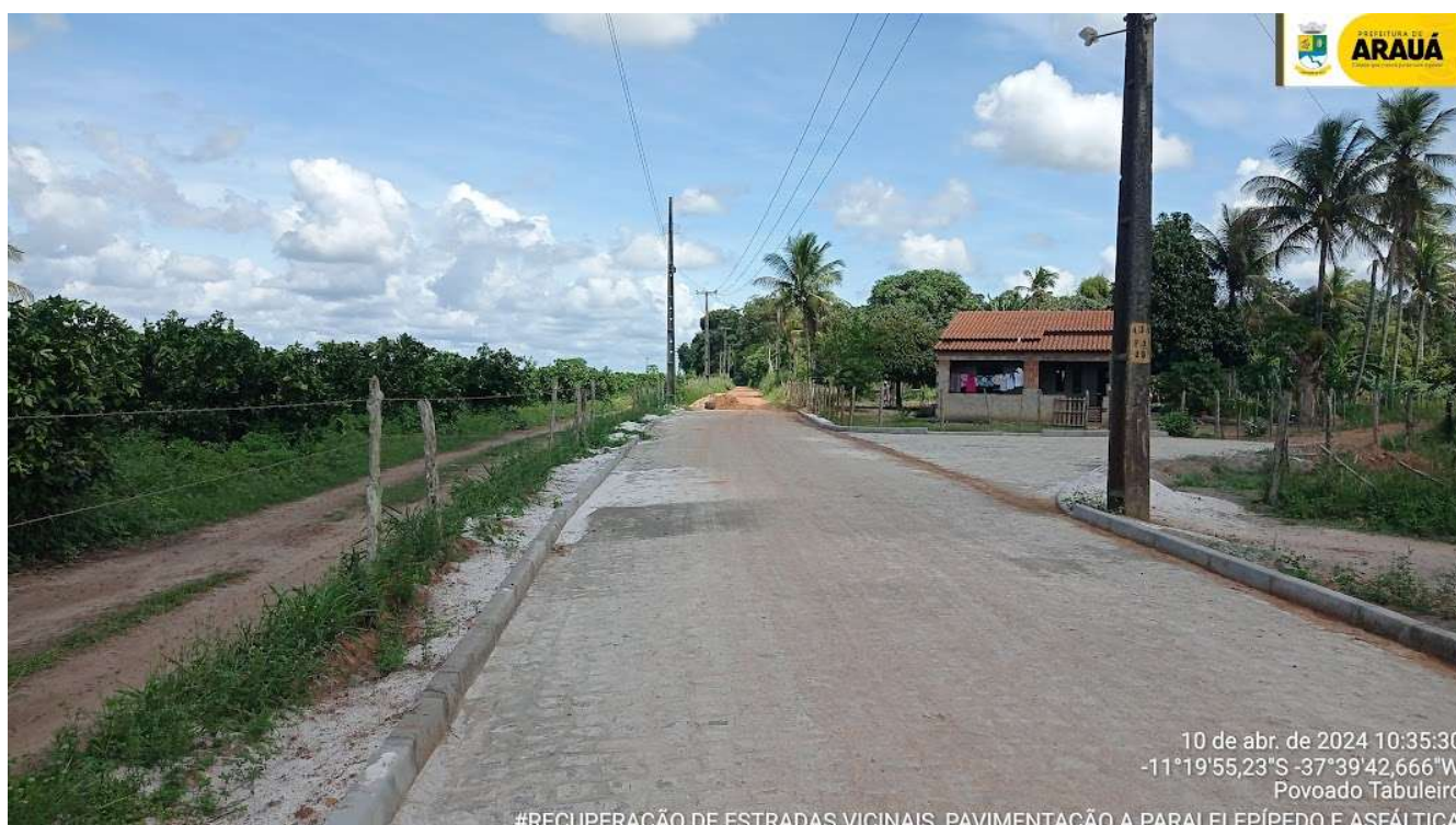
Pavimentação em paralelepípedo – Tabuleiro
