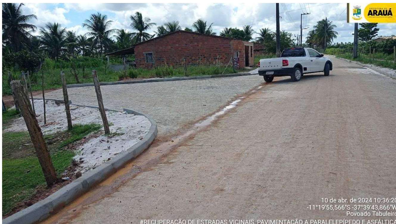
Pavimentação em paralelepípedo – Tabuleiro
