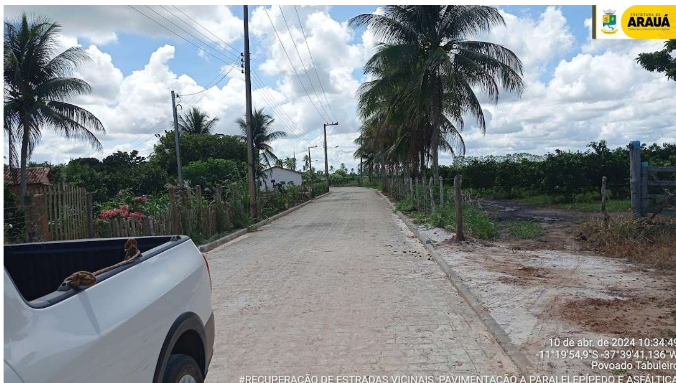
Pavimentação em paralelepípedo – Tabuleiro
