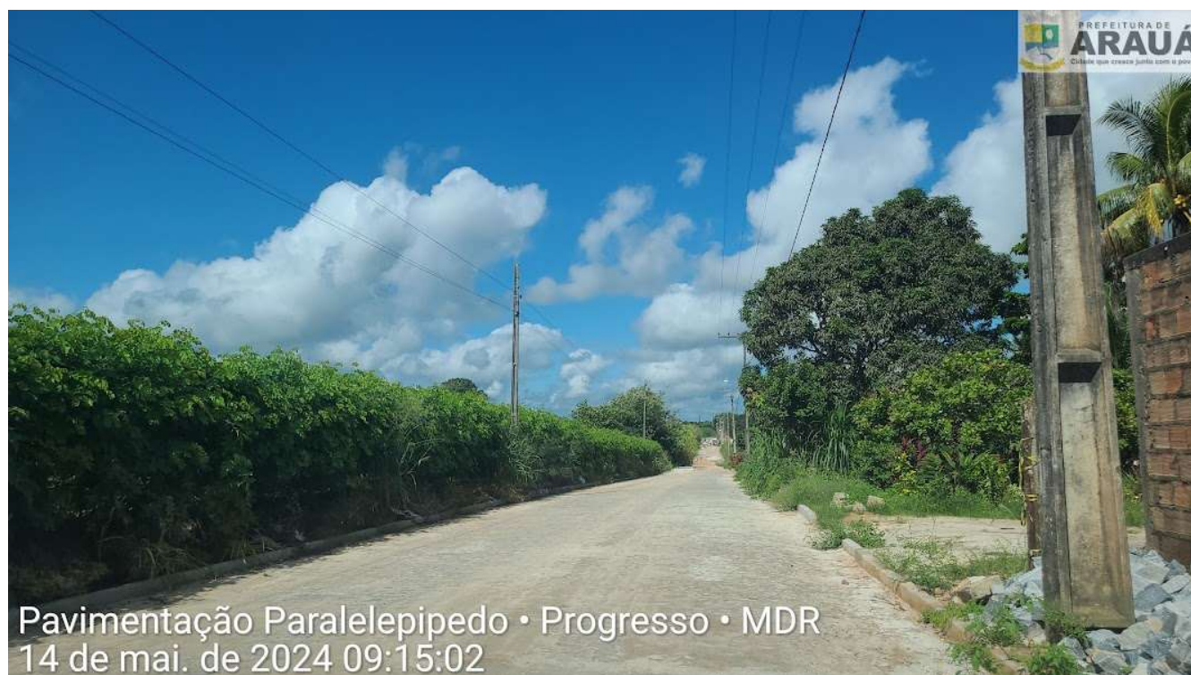
Pavimentação em paralelepípedo – Progresso
