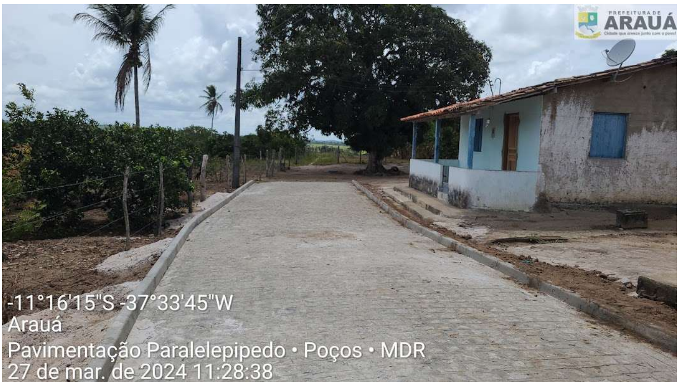
Pavimentação em paralelepípedo – Poços
