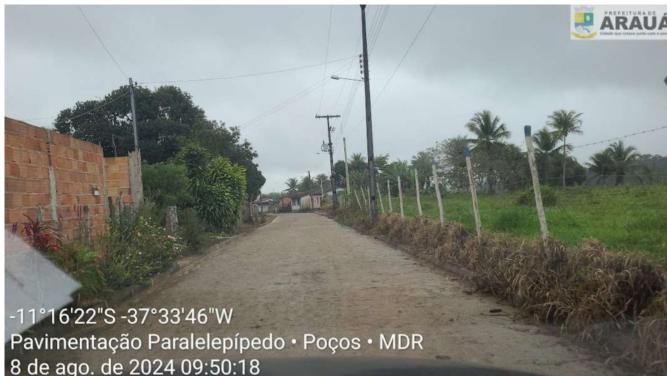
Pavimentação em paralelepípedo – Poços
