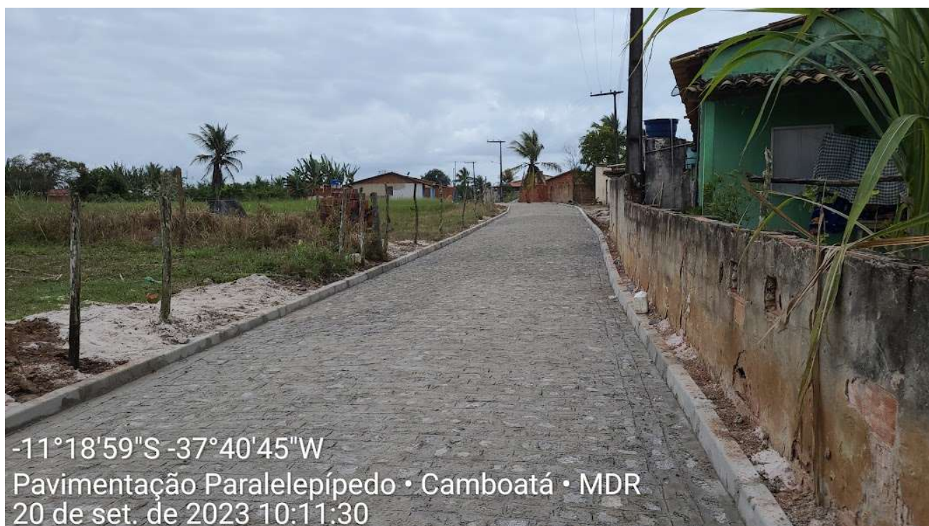
Pavimentação em paralelepípedo – Camboatá
