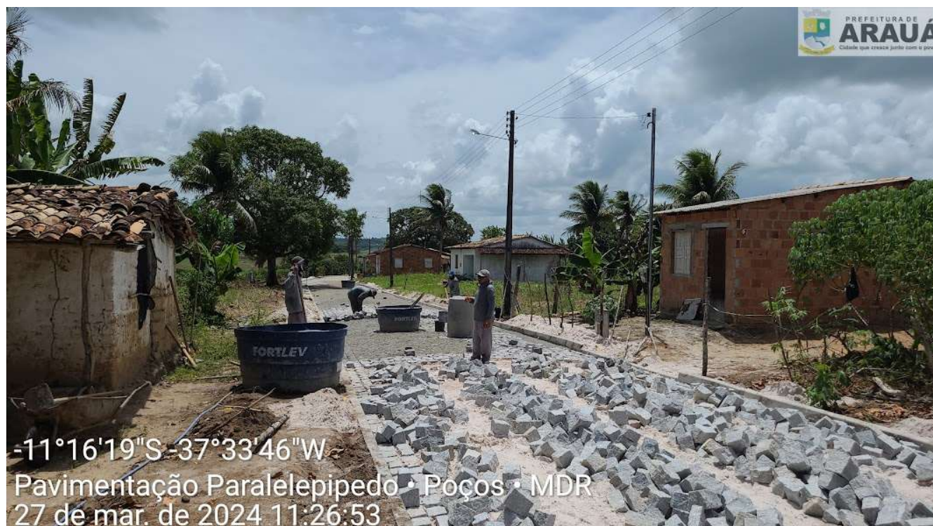
Pavimentação em paralelepípedo – Poços
