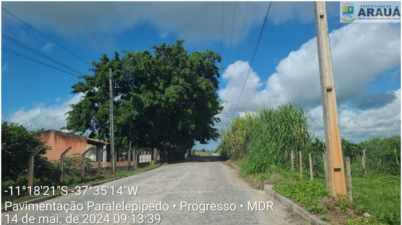
Pavimentação em paralelepípedo – Progresso
