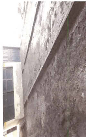
EXECUÇÃO DE CONTRAPISO
