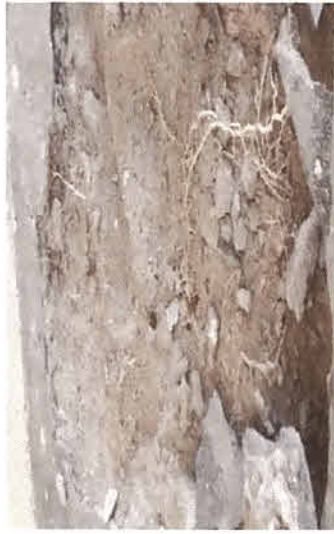
DEMOLIÇÃO DE PISO
