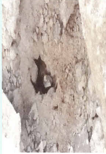
DEMOLIÇÃO DE PISO
