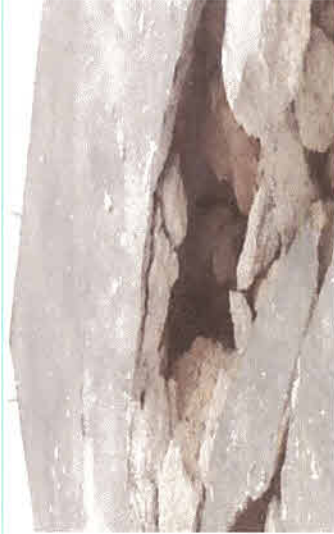
DEMOLIÇÃO DE PISO
