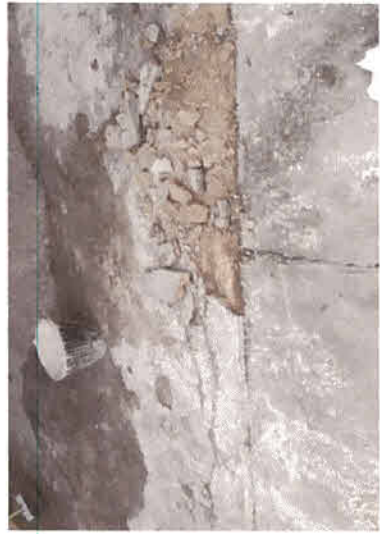
DEMOLIÇÃO DE PISO
