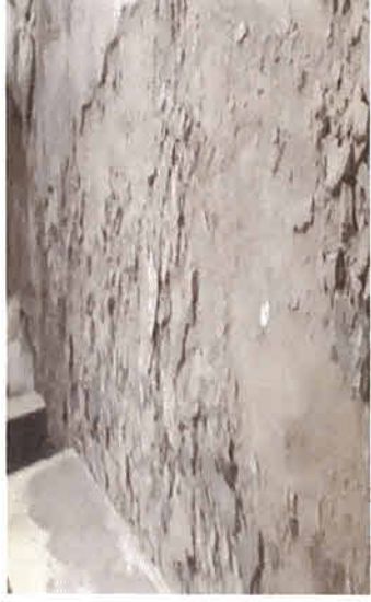
DEMOLIÇÃO DE PISO
