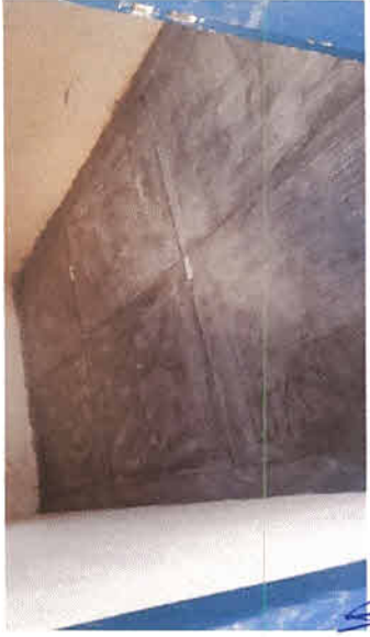
EXECUÇÃO DE CONTRAPISO
