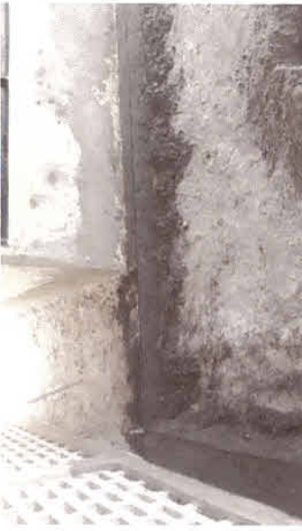
EXECUÇÃO DE CONTRAPISO
