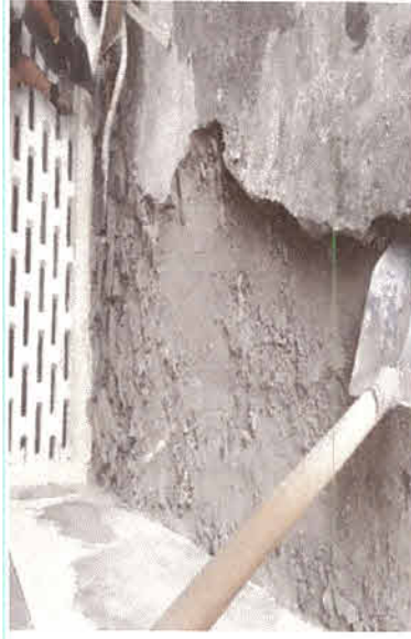
DEMOLIÇÃO DE PISO
