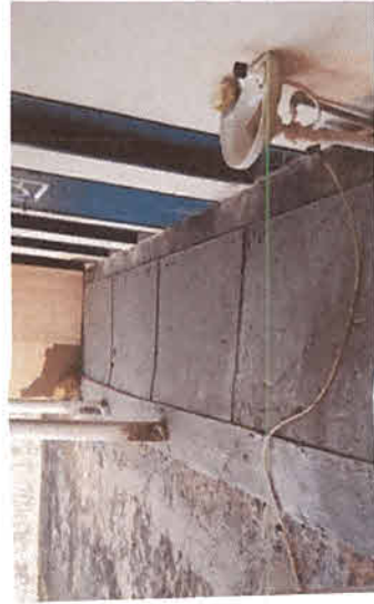
EXECUÇÃO DE CONTRAPISO
