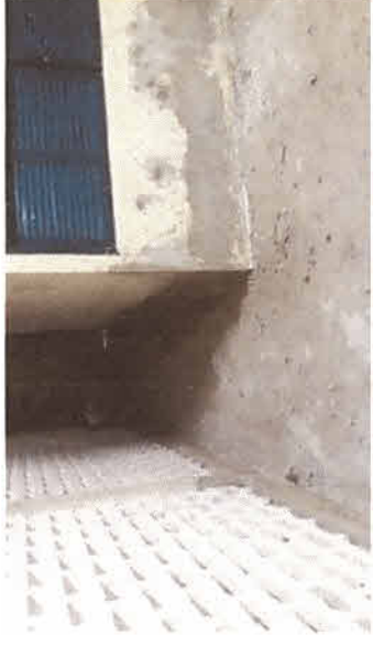
DEMOLIÇÃO DE PISO
