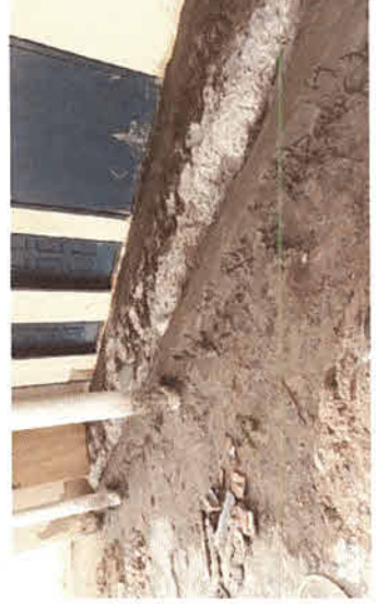
ATERAMENTO E CONTRAPISO
