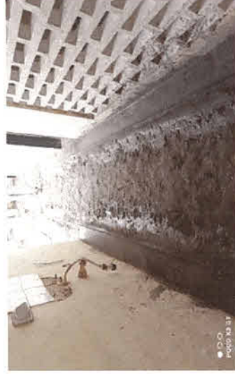
ATERAMENTO E CONTRAPISO
