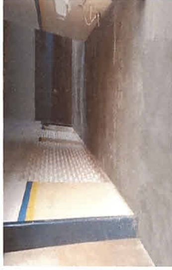
REGULARIZAÇÃO DE BASE
