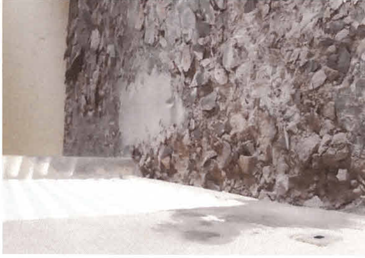
DEMOLIÇÃO DE PISO
