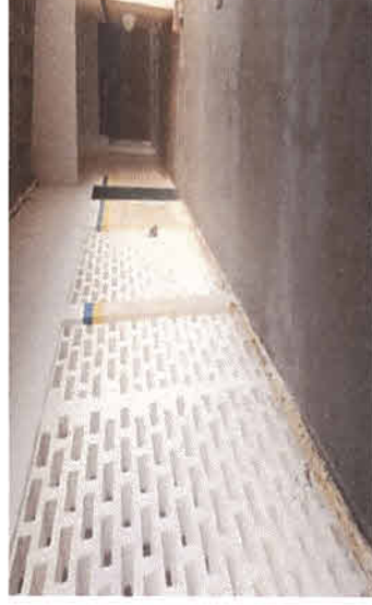
REGULARIZAÇÃO DE BASE
