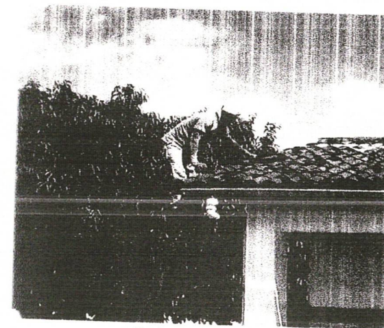
Revisão de Cobertura
