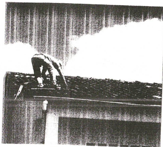
Revisão de Cobertura
