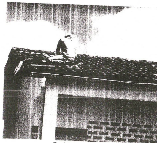
Revisão de Cobertura
